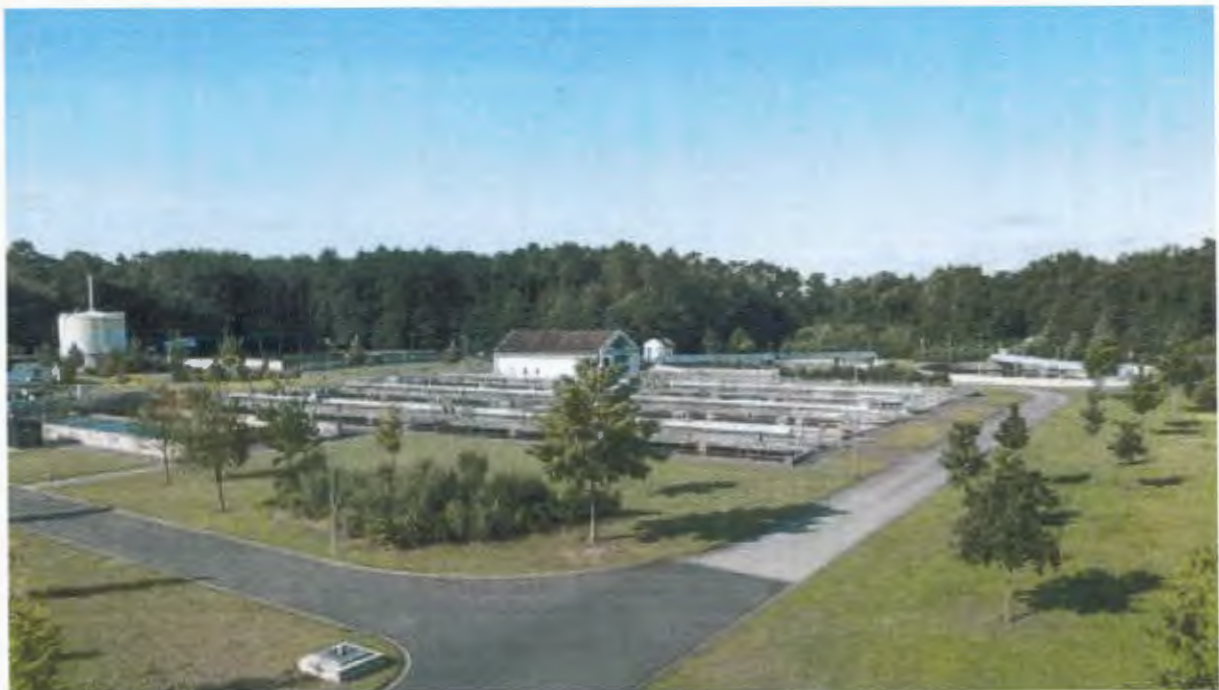
Kläranlage in Langen Bild © Abwasserverband Langen Egelsbach Erzhausen
