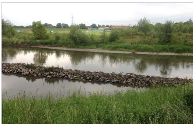
Bild 3: Renaturierungsmaßnahme beim Gronauer Hof
